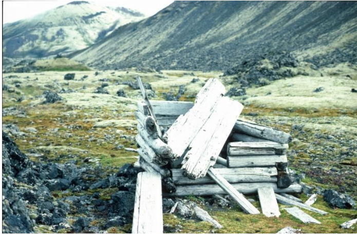
Ukjent bygg i Sørbukta 1986
