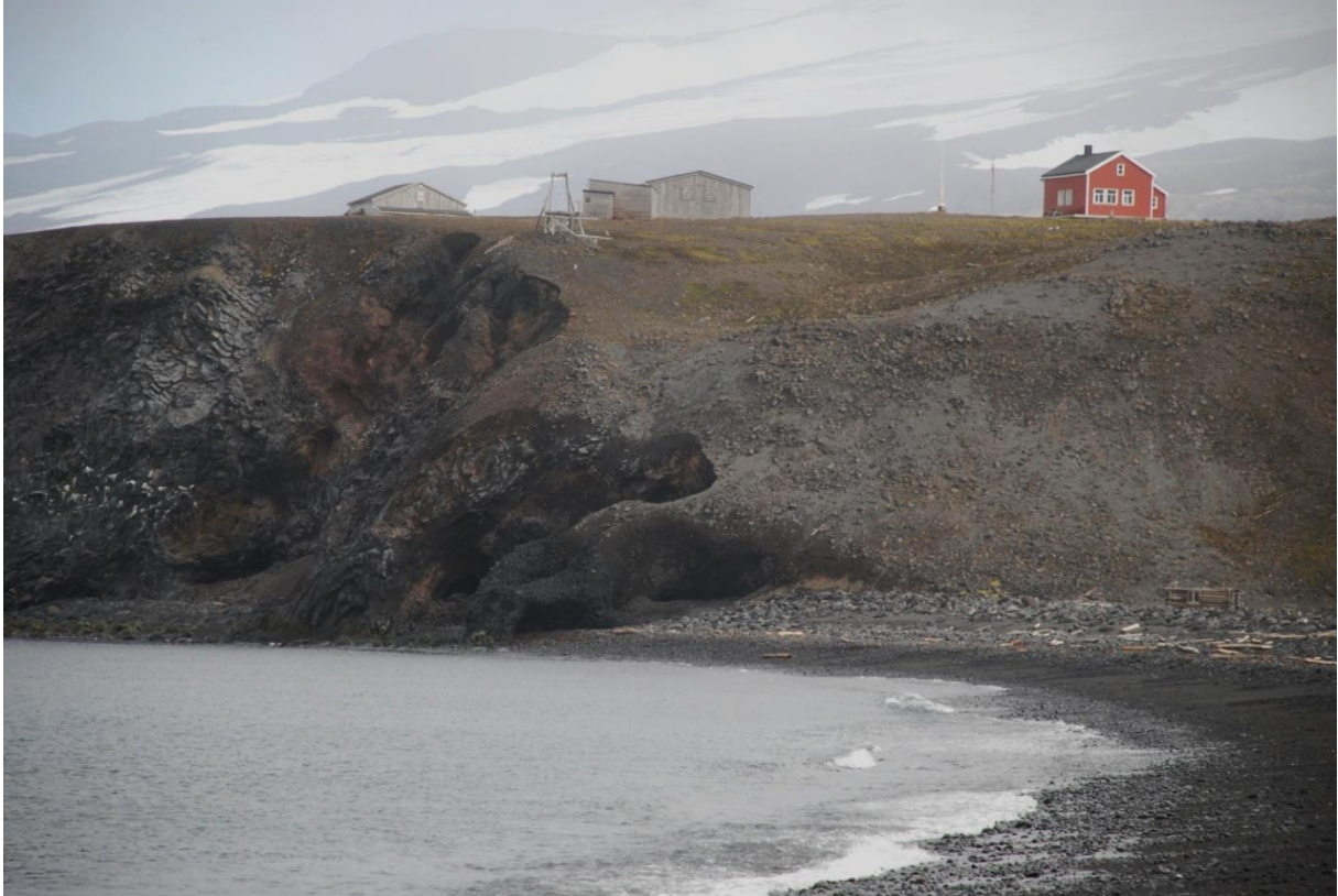
Erosjonens innvirkning ved et fredet taubaneanlegg (2008) over og kulturminner i Maria Muschbukta (2013) under
